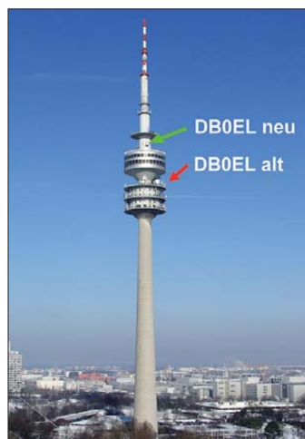
Vormaliger und neuer Standort von DB0EL im Münchner Olympiaturm
