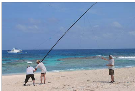
DL5LYM, DJ7EO und DL3DXX beim Aufstellen einer 40-m-GP für ein 4-Square
